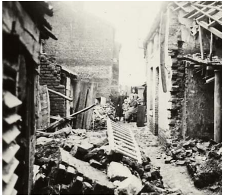
Vue des dégâts à Seraing. Photo : AIDE.
