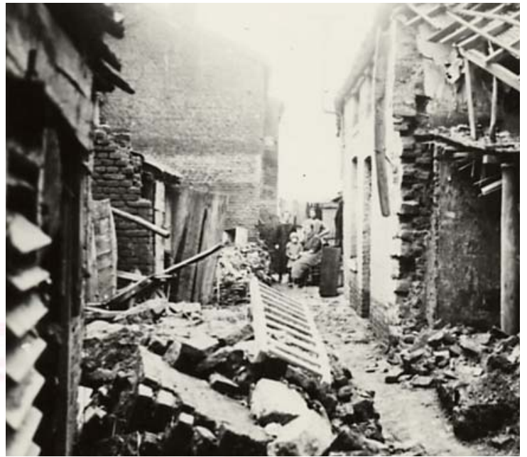
Vue des dégâts à Seraing. Photo : AIDE.
