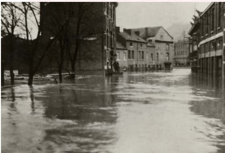
Le quartier de la gare de Tilleur sous les eaux. Photo : AIDE.
