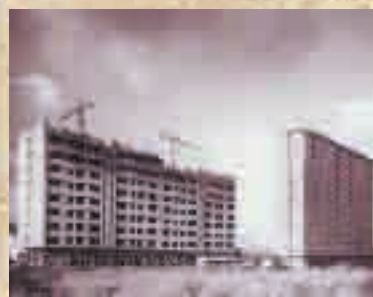
Résidence Bergerie en construction – 1955 Photographie tirée de La Maison sérésienne : 75 ans : un passé garant de l'avenir . Collection IHOES. Seraing
